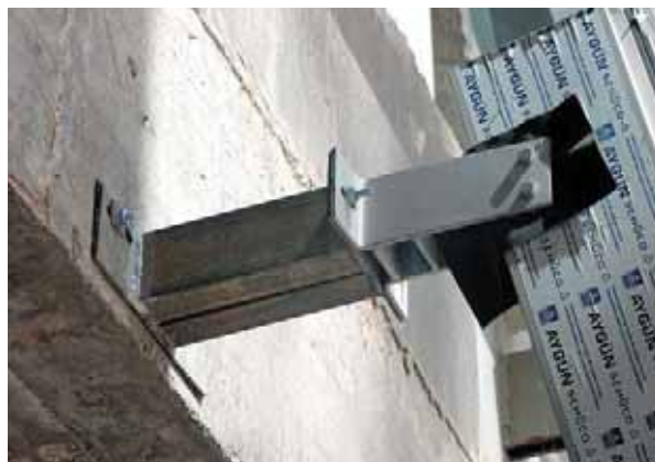
Монтаж светопрозрачных конструкций
