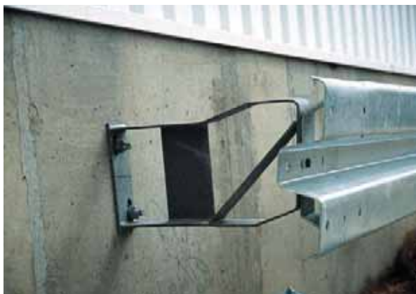
Монтаж дорожных ограждений
