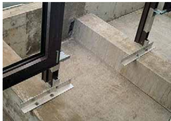
Монтаж витражных конструкций
