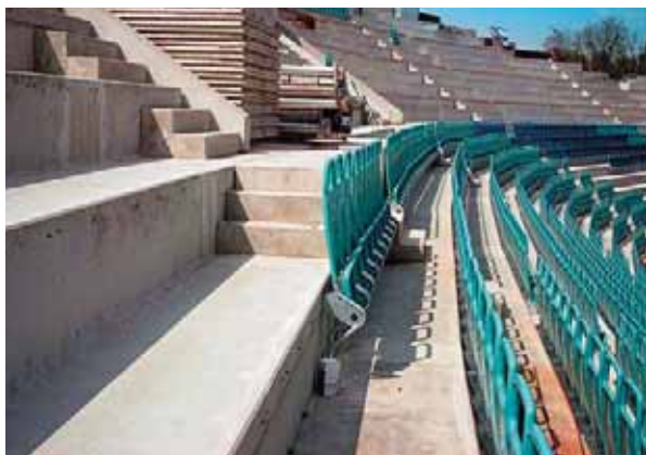
Монтаж кресел стадионов
