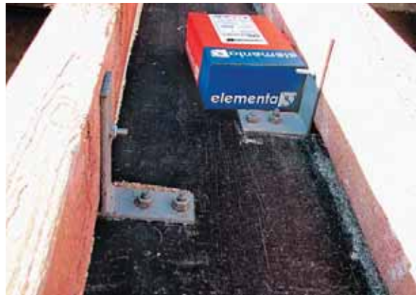
Монтаж стропильных балок
