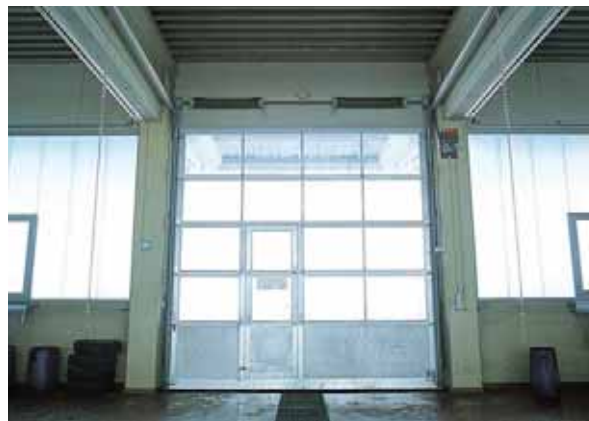
Монтаж автоматических ворот
