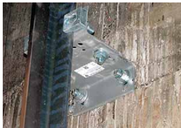
Монтаж лифтовых направляющих
