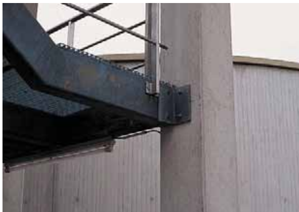
Монтаж лестничных маршей
