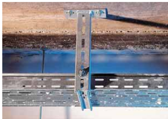
Монтаж инженерных систем
