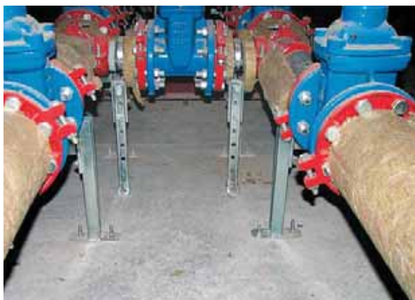
Монтаж инженерных систем
