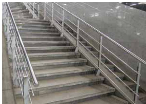
Монтаж перильных ограждений
