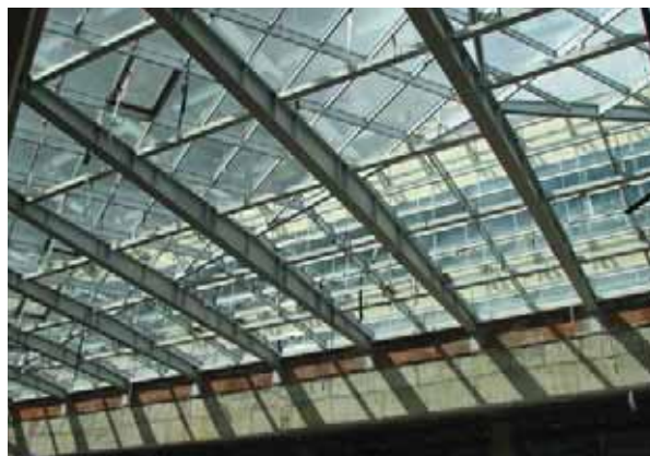
Монтаж балок перекрытия
