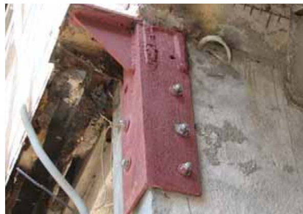
Монтаж опорного столика
