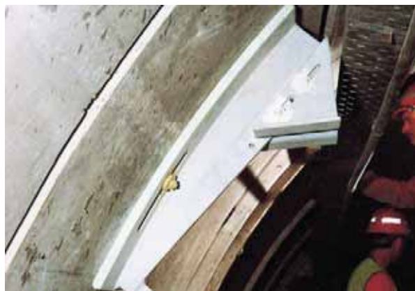
Монтаж тоннельных коммуникаций
