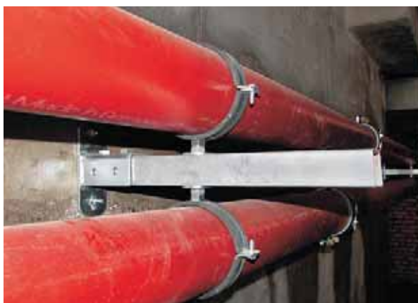
Монтаж инженерных систем
