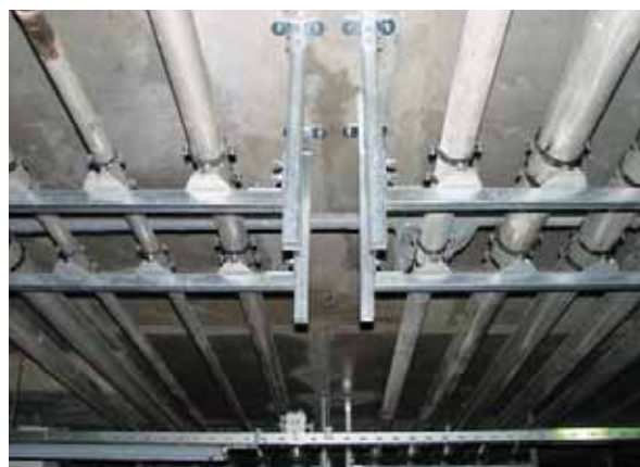
Монтаж инженерных систем
