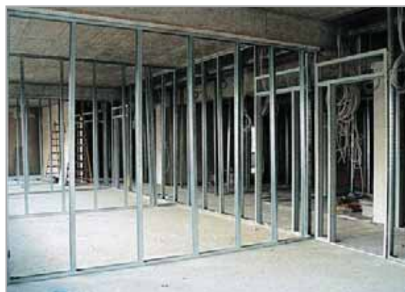
Монтаж профиля для внутренних перегородок
