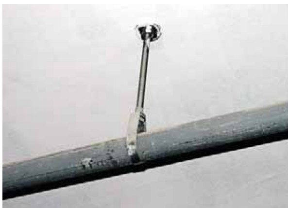
Монтаж спринклерных систем пожаротушения
