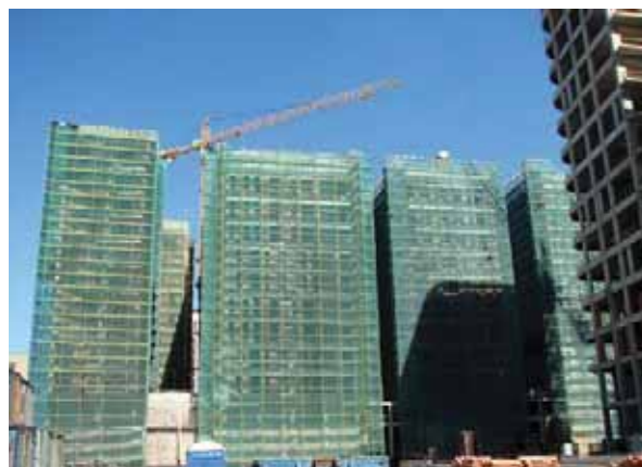
Монтаж строительных лесов
