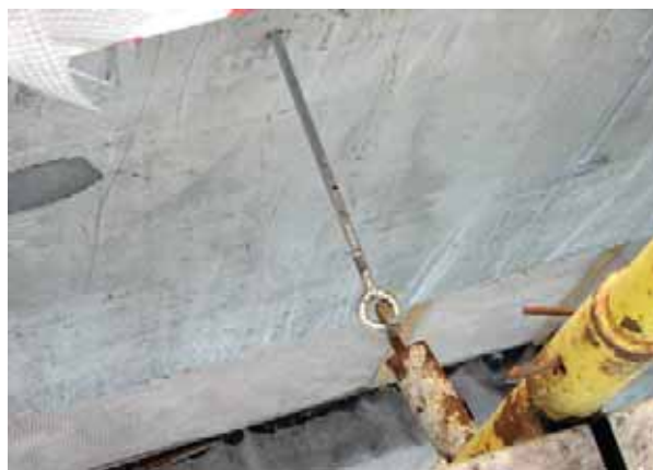
Монтаж строительных лесов
