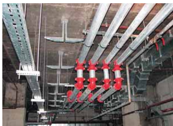
Монтаж инженерных систем
