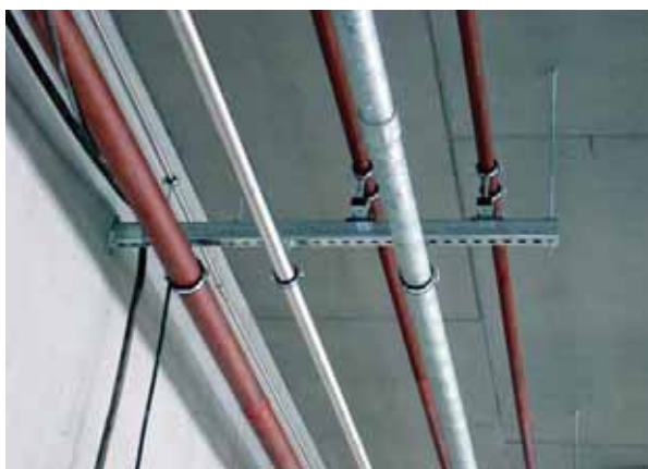
Монтаж инженерных систем
