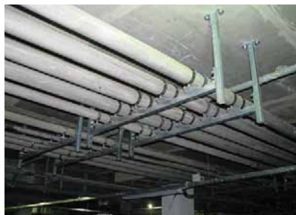
Монтаж инженерных систем
