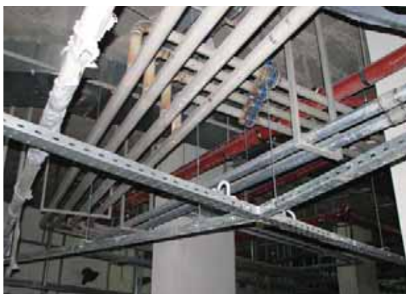
Монтаж инженерных систем
