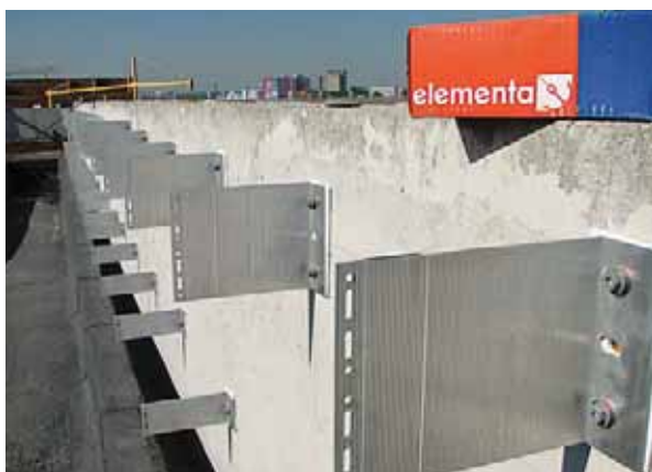
Монтаж кронштейнов НФС
