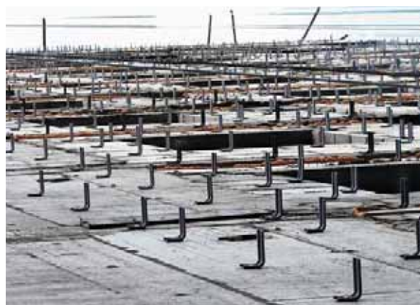
Монтаж кронштейнов НФС
