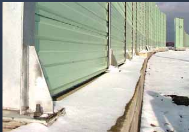
МОНТАЖ ШУМОЗАЩИТНЫХ ЭКРАНОВ
