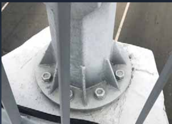
МОНТАЖ КОНСТРУКЦИЙ В РАСТЯНУТУЮ ЗОНУ БЕТОНА
