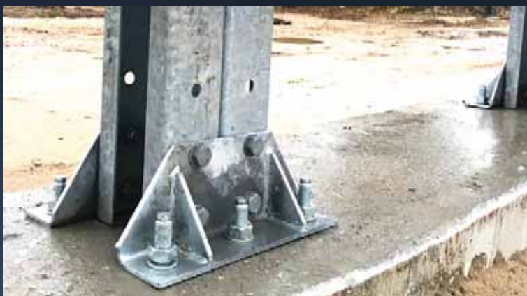
МОНТАЖ КОНСТРУКЦИЙ В РАСТЯНУТУЮ ЗОНУ БЕТОНА
